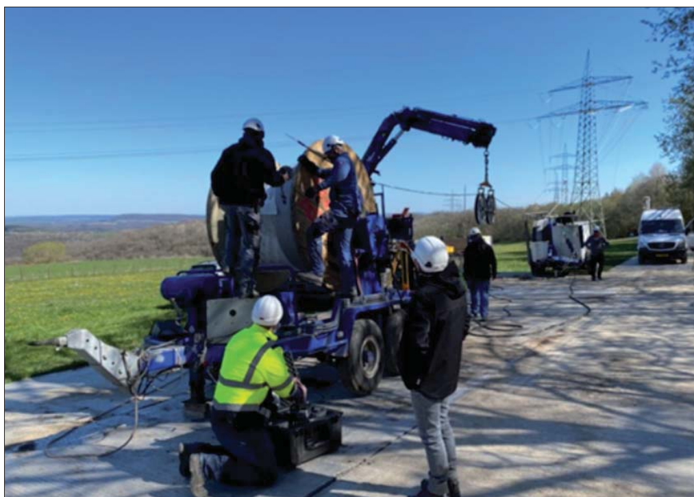
Figura 9 Personale prepara il conduttore ACCC che utilizza fibre ottiche incorporate nel nucleo composito
